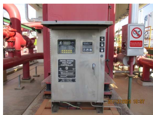
รูปที่ 57 Diesel Fire Pump
