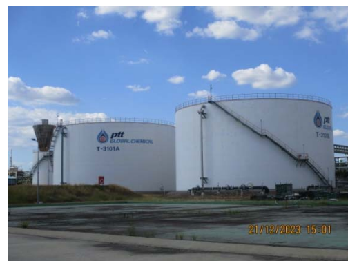
รูปที่ 56 Fire Water Tank
