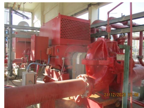
รูปที่ 58 Electric Fire Pump
