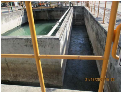
รูปที่ 9 Oil Separator
