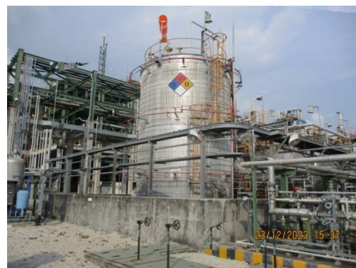
รูปที่ 34 คั่นคอนกรีตรอบถังกักเก็บ
