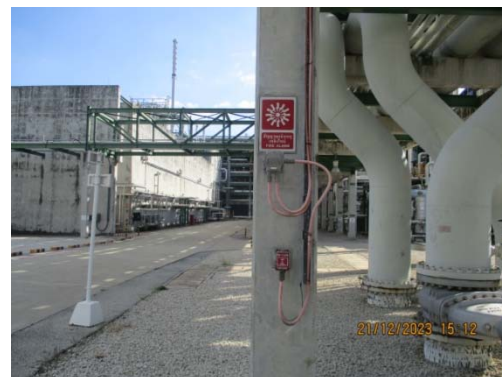
รูปที่ 50 Manual Pull Station
