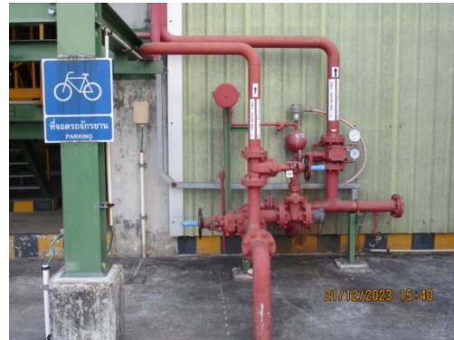
รูปที่ 42 Wet Alarm System
