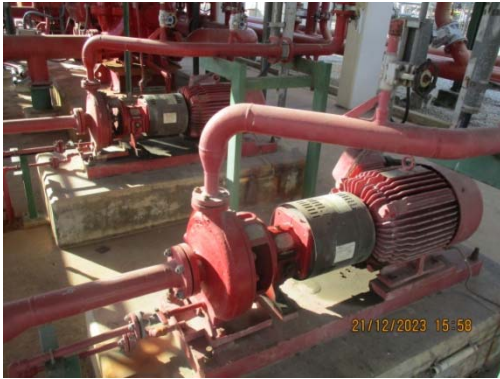
รูปที่ 59 Electric Jockey Pump
