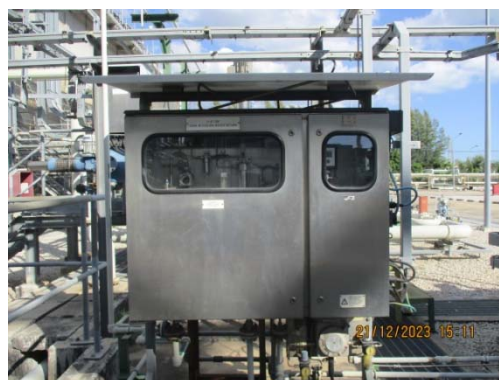
รูปที่ 16 Conductivity Online บริเวณท่อส่งกลับน้ำหล่อเย็น
