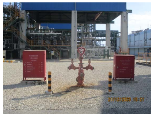
รูปที่ 46 Water Hydrant
