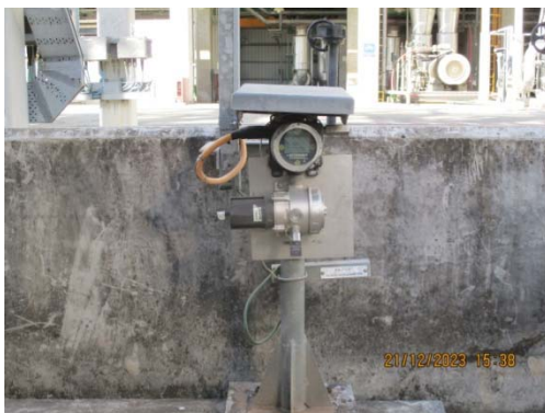
รูปที่ 49 Gas Detector
