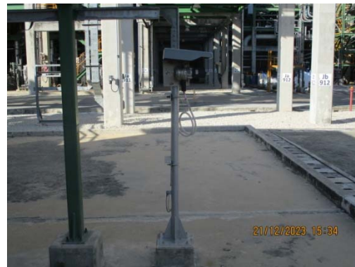
รูปที่ 36 Gas Detector บริเวณหน่วย RTO
