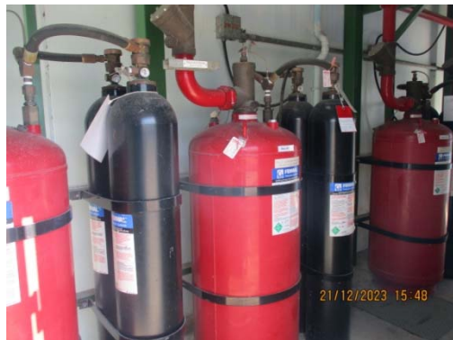
รูปที่ 53 Fixed Gas Fire Extinguisher System (FM-200)
