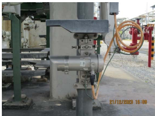
รูปที่ 51 Flame Detector
