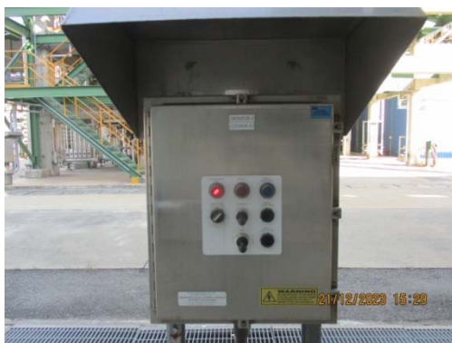
รูปที่ 45 Water Monitor Remote
