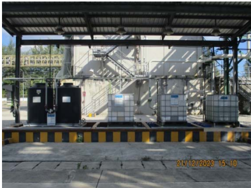
รูปที่ 41 ภาพของถังเก็บสารเคมีที่ปิดมิดชิดและ ท่อกักคร่อน
